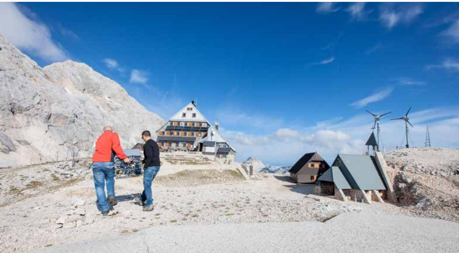
Postavljanje energetske učinkovite bazne postaje na Kredarici
