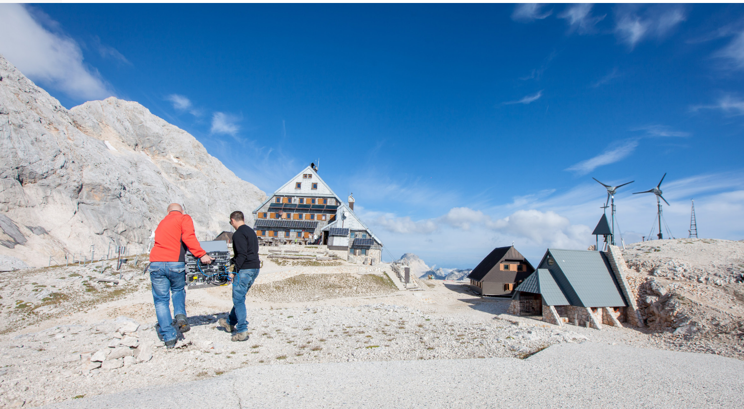
Postavljanje energetske učinkovite bazne postaje na Kredarici
