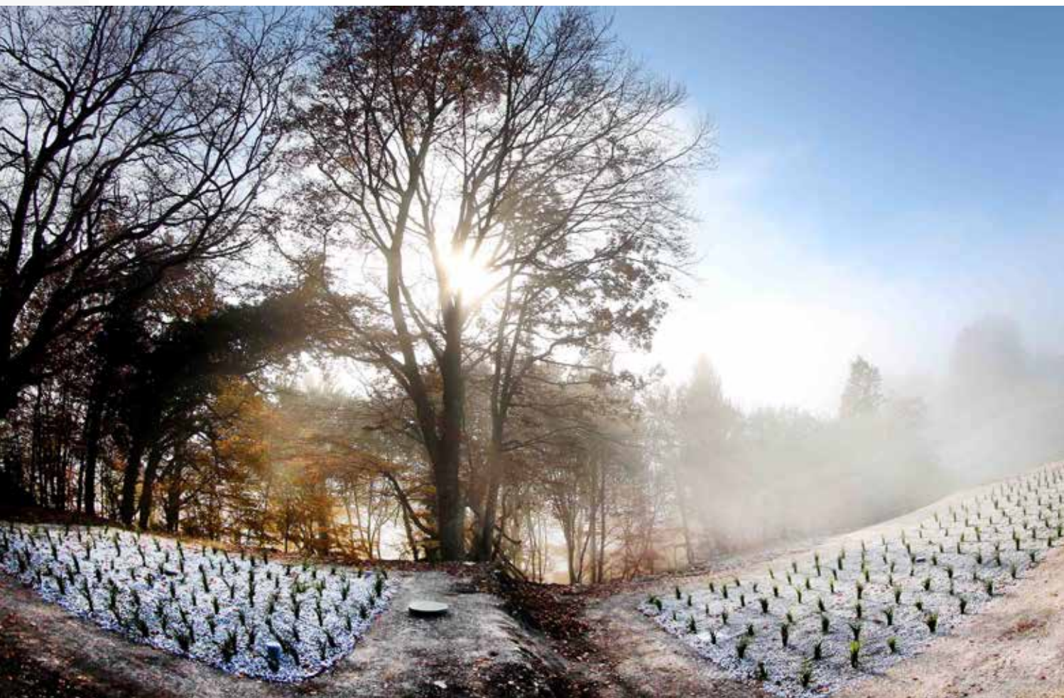
Rastlinska čistilna naprava na Lisci
